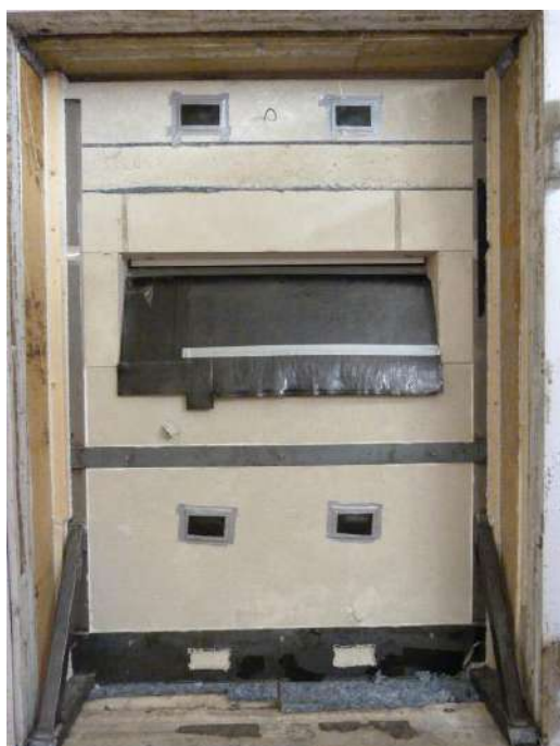
Vue du montage (côté émission) tablier enroulé
